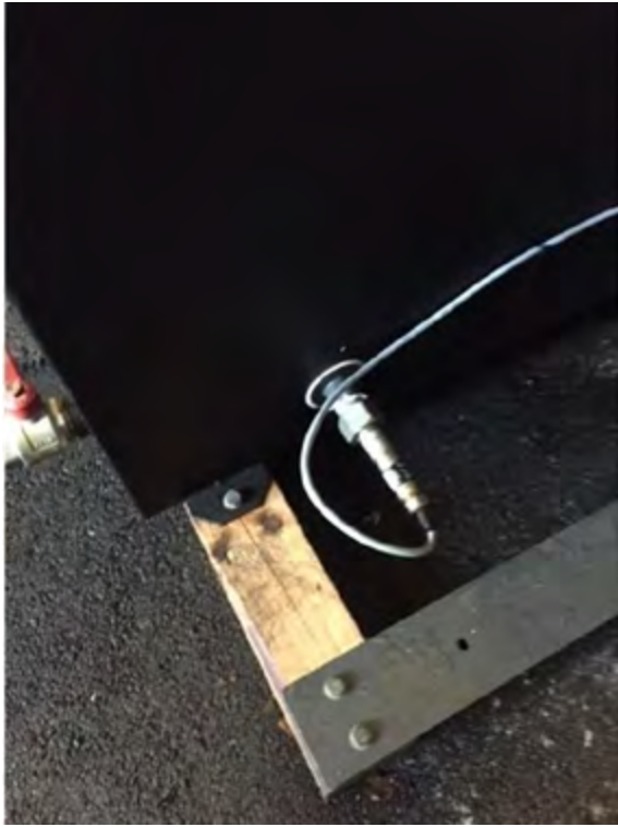
Figur 21. Givare i saturatorn som kontrollerar saltlösningens salthalt: från utsidan på bilden till vänster och från insidan på bilden till höger. Tips: Den högra bilden visar att operatören här valt att sätta ett buntband över sensorn för att underlätta rengöringen. Buntandet får inte vara för hårt åtdraget utan ska kunna löpa lätt över sensorn. Ta på ett par plasthandskar och dra buntandet fram och tillbaka för att göra rent sensorn!
