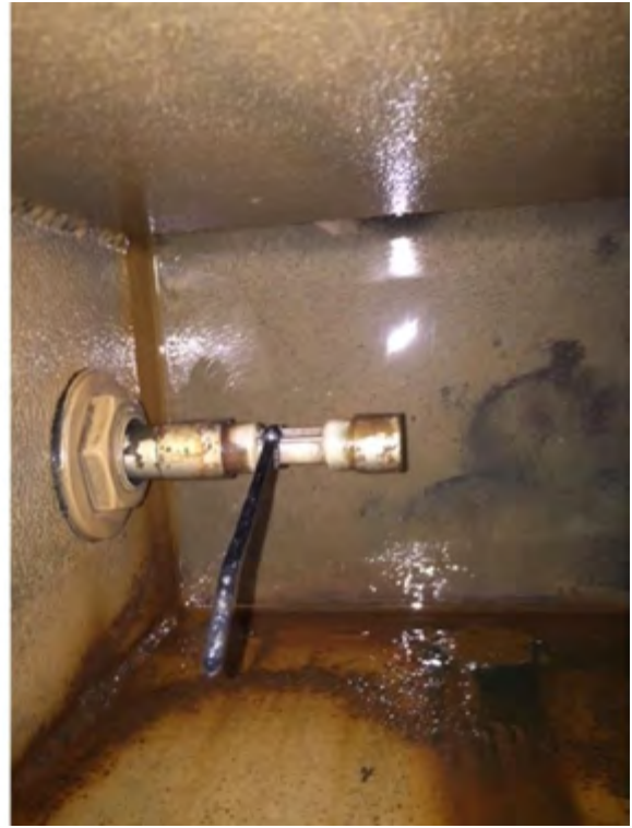
Figur 21. Givare i saturatorn som kontrollerar saltlösningens salthalt: från utsidan på bilden till vänster och från insidan på bilden till höger. Tips: Den högra bilden visar att operatören här valt att sätta ett buntband över sensorn för att underlätta rengöringen. Buntandet får inte vara för hårt åtdraget utan ska kunna löpa lätt över sensorn. Ta på ett par plasthandskar och dra buntandet fram och tillbaka för att göra rent sensorn!
